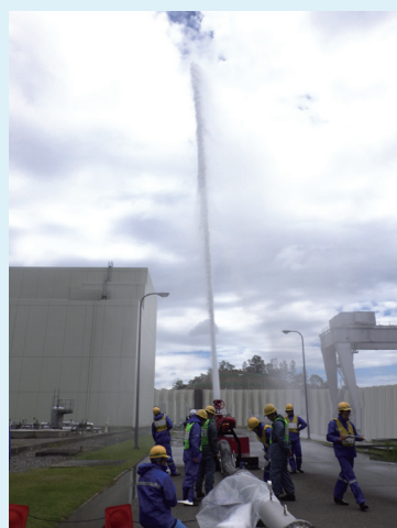
放水試験の様子
