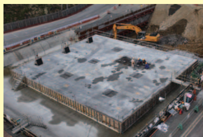
地下軽油タンクの上の コンクリート工事を実施 (平成28年10月撮影)
