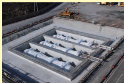
地下に軽油タンク(3基)を設置 (平成28年3月撮影)
