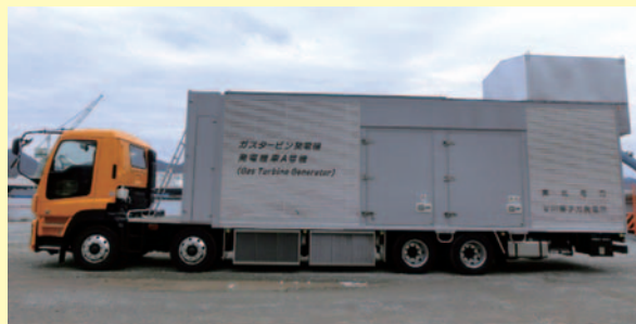
ガスタービン発電機(車両に搭載)
