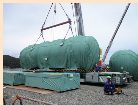
陸揚げのため吊り上げられる軽油タンク
