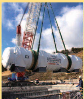
大型軽油タンク設置工事の様子
