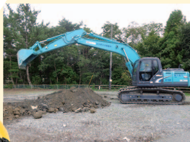
バックホウによる土砂撤去
