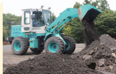
ホイールローダによる土砂撤去
