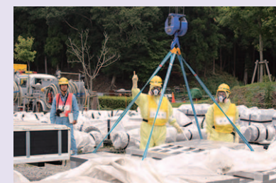
重機による必要機材のつり上げ
