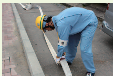
ホースの敷設
