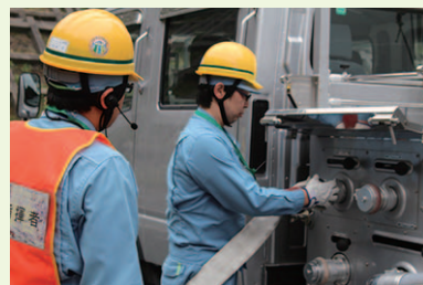
代替注水車へのホースの接続
