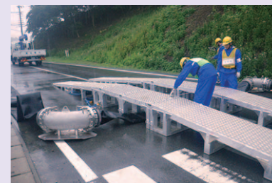
仮設ブリッジの設置
