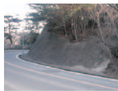
モルタル吹付工の施工例
