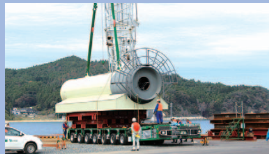
発電所岸壁に陸揚げし特殊車両で搬送
