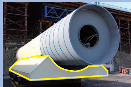
黄色で囲んだ箇所は、海側に面する遮水板。鋼管杭と遮水板の接合は工場で行い品質を確保している
