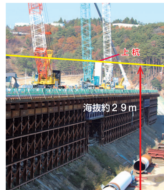
上杭の建込みが始まった防潮堤
