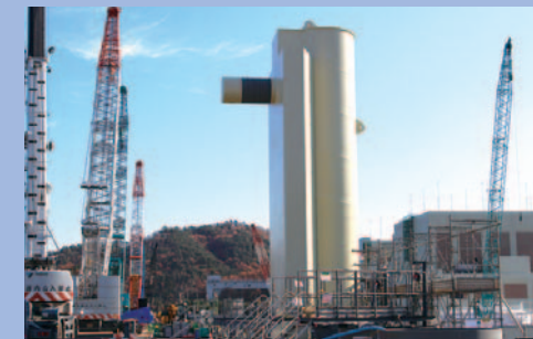
設置済の下杭に上杭を建込む
