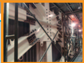
鉄骨部材を追加設置
