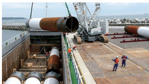
発電所岸壁に陸揚げ
