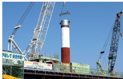
鋼管杭を大型クレーンで吊り上げ、建込む
