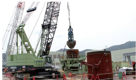
鋼管杭の建込みスペースを掘削
