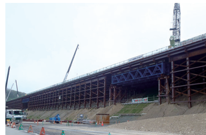
鋼管杭を建込むための作業構台
