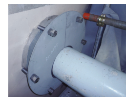
貫通部水密化施工例
