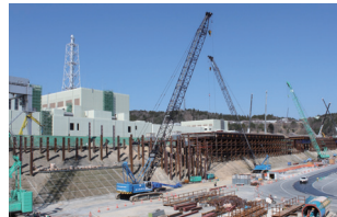
かさ上げ工事が進む防潮堤
