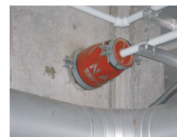
貫通部シール施工例
