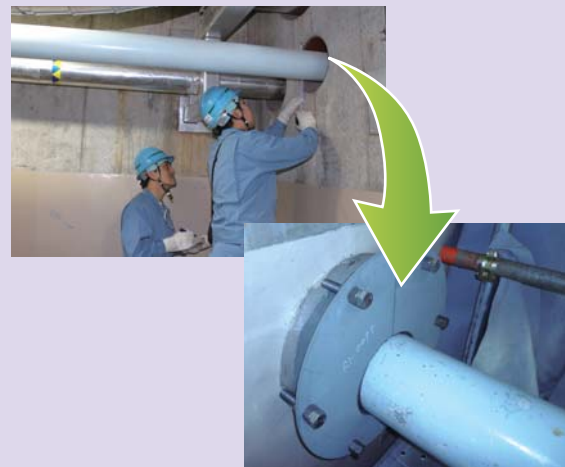
配管等が壁を貫通している個所をシール施工
