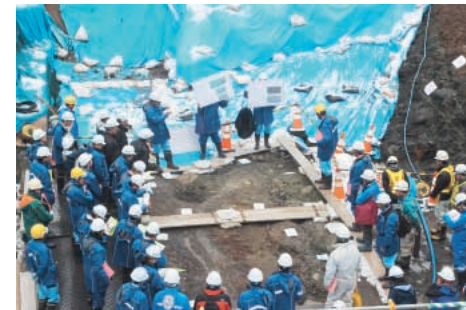
f-1断層の現地調査状況
