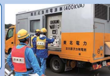
「発電機の起動操作」の様子
