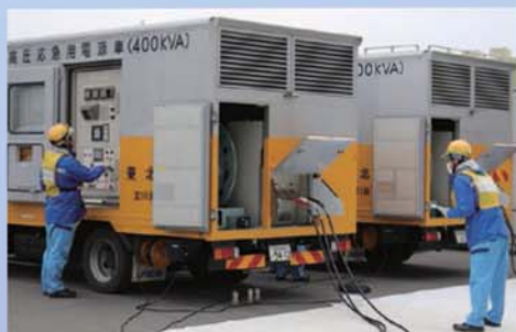
「ケーブル接続部の確認」の様子
