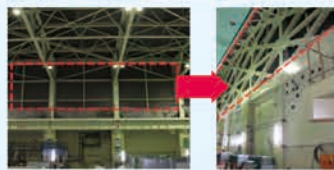
3号機原子炉建屋の耐震補強工事について説明。
