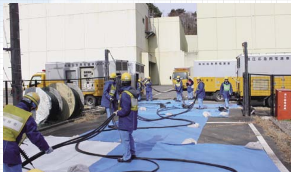
▲電源車のケーブルを接続する電源確保訓練
