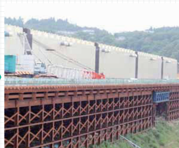
鋼管杭の建て込み工事が進む (2015年8月撮影)
