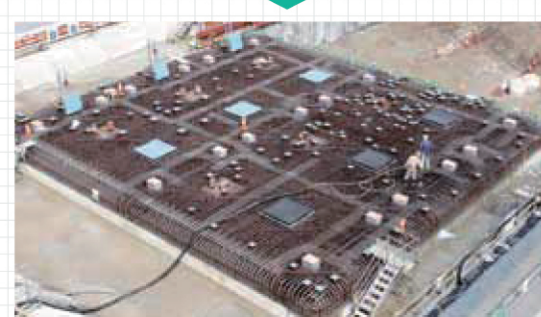
設置工事が進む(2016年9月撮影)
