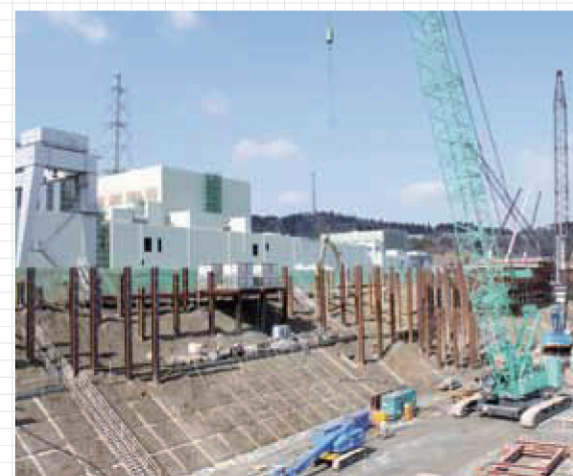
2013年5月から海拔29mへのかさ上げ工事を開始 作業構台建設(2014年3月撮影)
