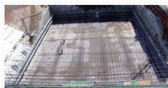
淡水貯水槽の本体工事を開始(2015年6月撮影)
