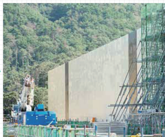
2016年8月に鋼管杭の建て込み完了 (2016年9月撮影)
