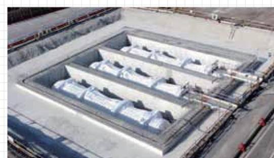
燃料タンクを地下に据付(2016年3月撮影)
