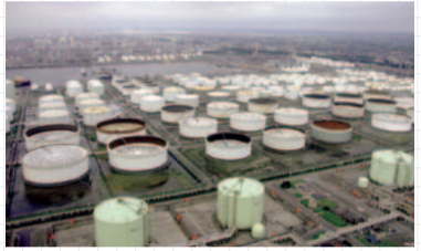
石油備蓄基地
