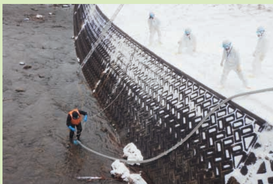
敷地内を流れる小老部川からの取水
