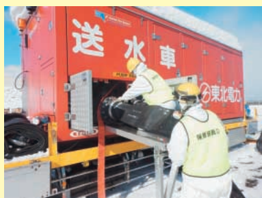
海水を汲み上げるホースを送水車へ接続する様子
