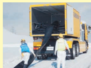
海水熱交換器建屋までホースを延長する様子
