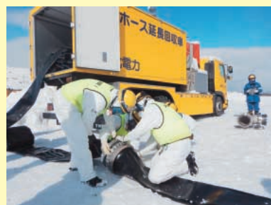
送水車と延長ホースを接続する様子
