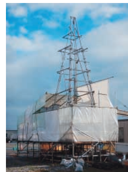
ボーリング調査
