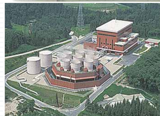
発電所1基あたりでは日本最大の出力実績を持つ、柳津西山地熱発電所(福島県)
