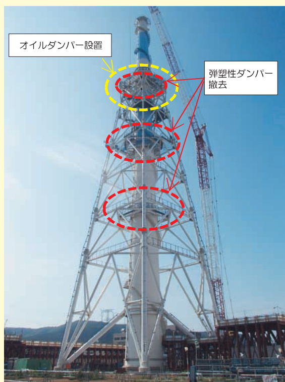
【工事状況／7月2日撮影】
