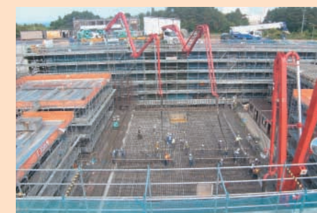
【淡水貯水槽コンクリート打設状況／6月18日撮影】
