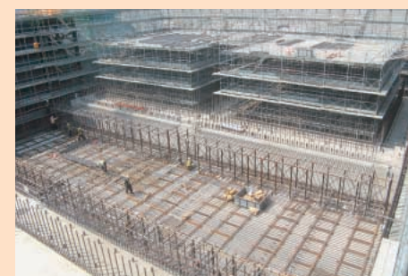
【淡水貯水槽鉄筋組立て状況／5月29日撮影】
