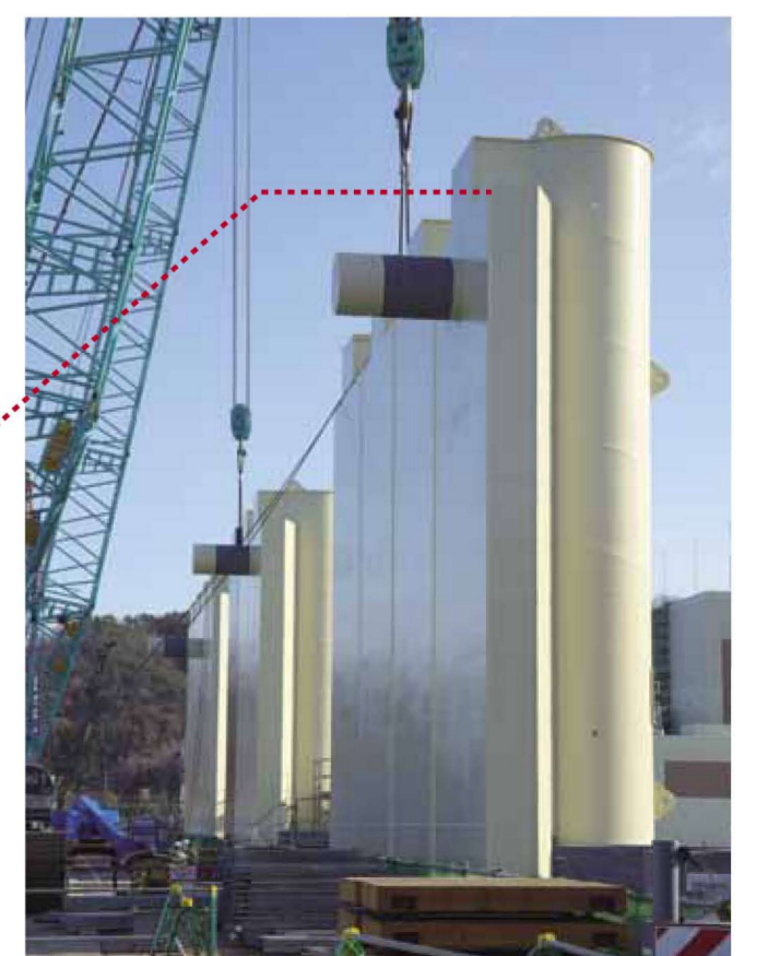
鋼管は168本打ち込みます
