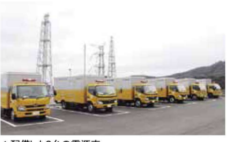
▲配備した6台の電源車
