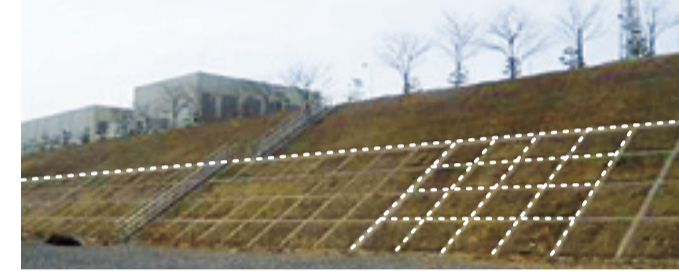
◀2号機建設時に9.7mの高さまでコンクリートで補強した敷地法面(破線例示)震災時の津波にも耐えることができた
