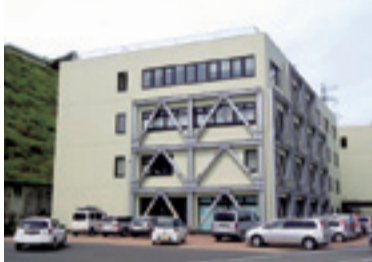
外壁の筋交いを設置した旧事務棟震災時には事務棟として使用していた
