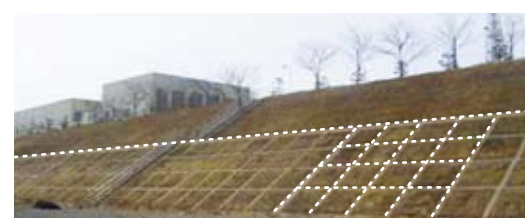
▲2号機建設時に9.7mの高さまで設置した法面防護工(破線例示)
