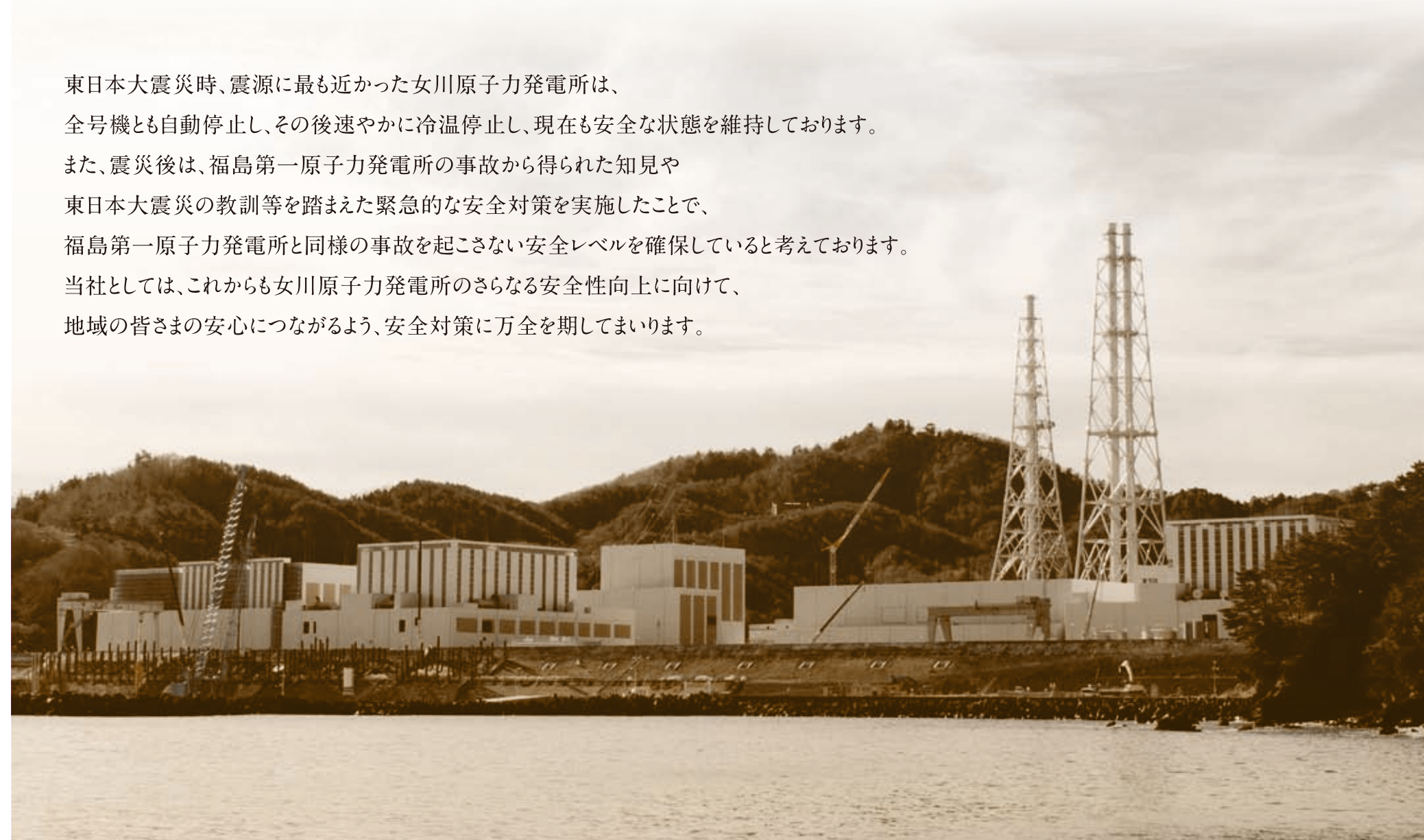
▲防潮堤のかさ上げ工事が進む女川原子力発電所
