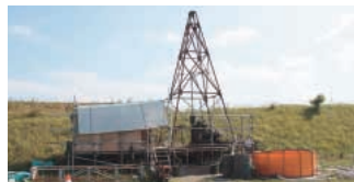
ボーリング調査
