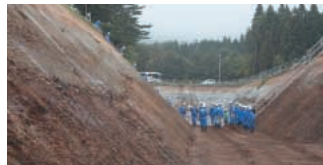
トレンチ調査
