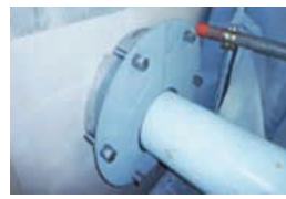
貫通部シール施工例
