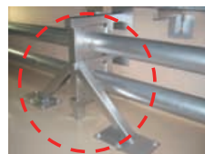
耐震工事の例
