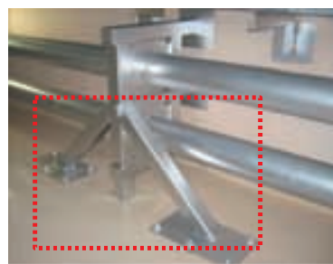
施工例（サポートの強化）
