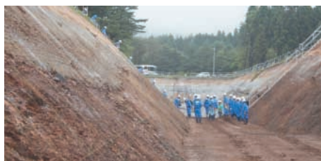
地質調査の例（トレンチ調査）
