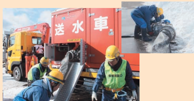
代替海水ポンプ(送水車)からホースを敷設
