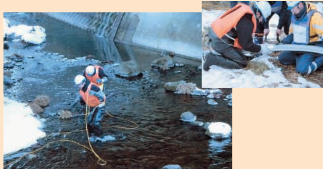
敷地内を流れる小老部川からの取水
