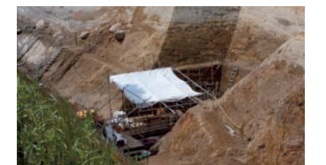
水平ボーリング調査 断層側面から水平にボーリングを行い、条線(ずれの方向を示す断層面の傷等)を調査
