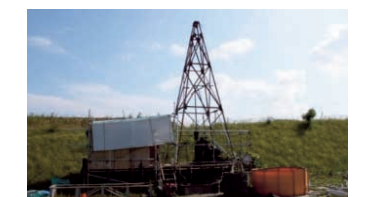
ボーリング調査 地下の岩石等を連続的に採取し、地質分布、断層破碎部の固結状況等を調査
