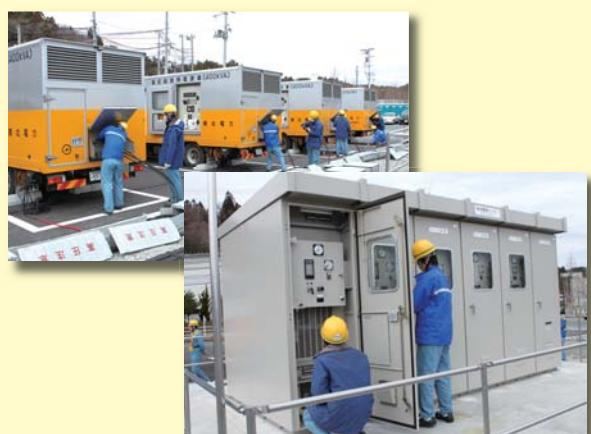
▶高台電源センターでは、あらかじめ電源車と高圧電源盤との接続ケーブルが敷設されているため、より迅速な電源供給が可能
