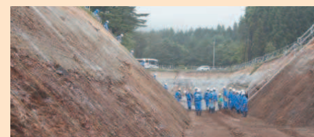
現地調査では、変動地形指摘箇所のトレンチ壁面を確認
