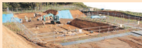
水平掘削面調査の様子
