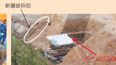
水平ボーリング調査の様子
