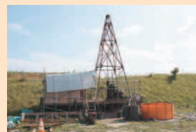
ボーリング調査の様子
