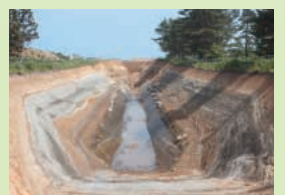
トレンチ調査状況
