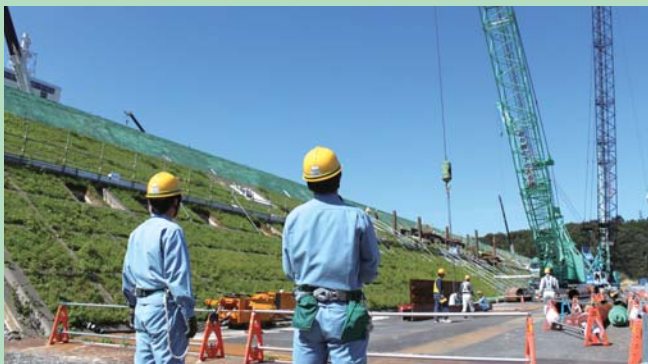
▶ 海側から防潮堤（海拔約17m）を望む。防潮堤の背後に鋼管杭が立ち上がり海拔約29mになる予定
