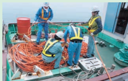
音波を受振するバイケーブルの敷設
