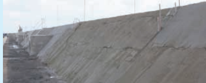
平成25年5月 本体工事完了
