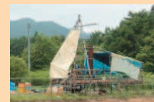
ボーリング調査
