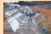
トレンチ調査 断層周辺の地質を溝状に掘削し、断層部の詳細な様子を観察する
