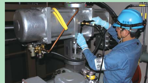
全交流電源喪失時を想定した 格納容器ベント弁現場操作訓練
