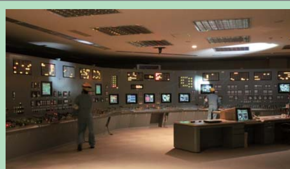
全交流電源喪失時を想定した シミュレーターによる運転訓練
