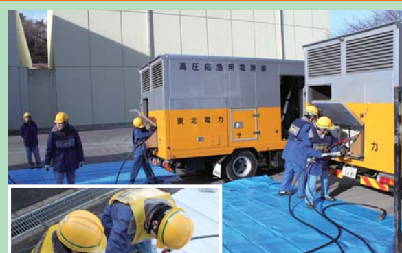
電源車の接続訓練
