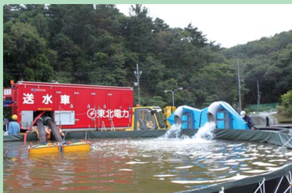
送水車（代替海水ポンプ）での送水訓練
