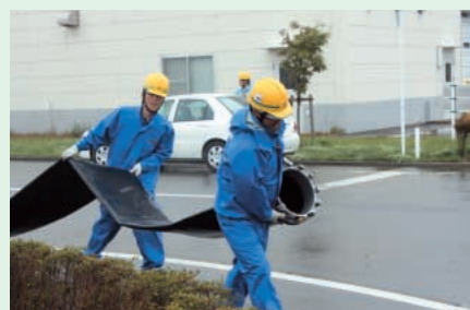
8月10日に行われた送水ホースの敷設訓練
