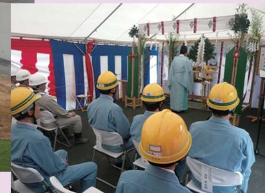
▲7月26日には工事関係者約20人が出席し、安全祈願祭が執り行われました
