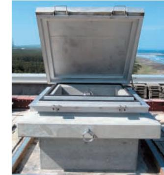
原子炉建屋屋上に設置したベント装置
