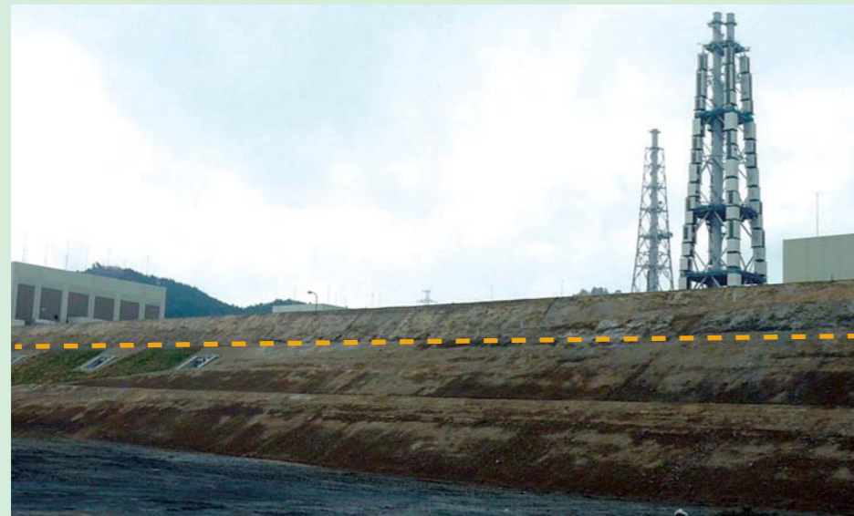
敷地高さとおわせ高さ約17メートル、長さ約600メートルの防潮堤
