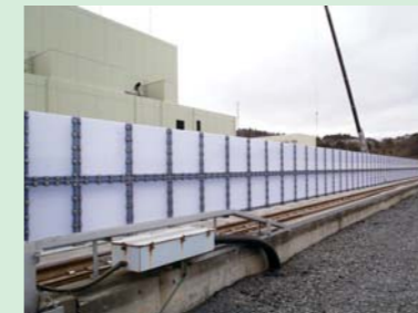
2号機海水ポンプ室の周囲に設置した防潮壁
