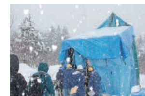
ボーリング調査の様子
