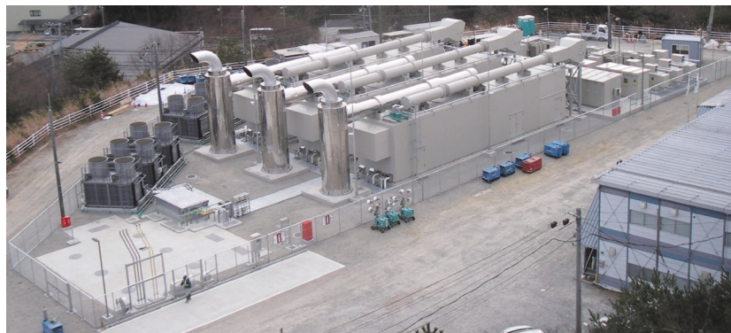
▲運用を開始した大容量電源装置(写真上)と大容量電源装置の基礎工事の様子(写真右上,右下)。鉄筋とコンクリートによるしっかりとした基礎の上に設置しています
