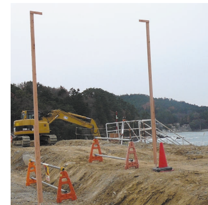
▲発電所敷地（高さ約14メートル）に、高さ約3メートル・長さ約600メートルの防潮堤を設置します。写真の木柱の頂部が海面から約17メートルの高さになります
