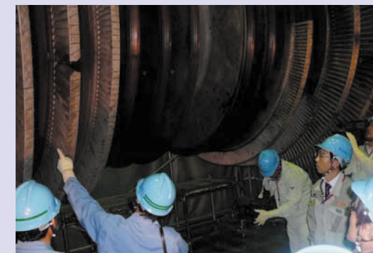
▲補修を進めている3号機低圧タービンの現場確認の様子
