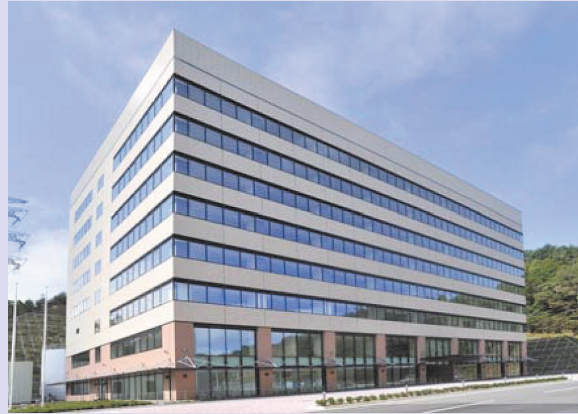
▲完成した事務新館。免震構造を採用し、耐震性の向上を図っています
