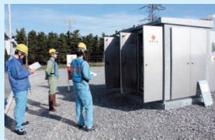
大容量電源装置の接続操作前の点検をしている様子
