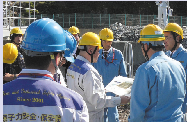
▲津波により倒壊した1号機重油タンクの状況確認の様子
