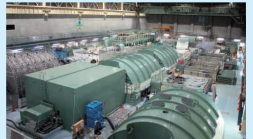
第3回定期検査の様子(タービン建屋)
