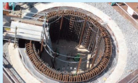
現在、支持鉄塔の基礎部分の新設する工事をしています
