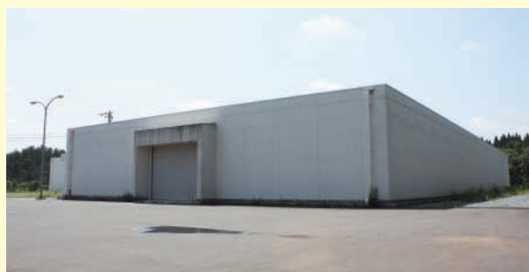
現在の固体廃棄物貯蔵所 (南側に同規模の貯蔵所を増設する予定)
